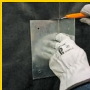
**1** Corta el **Ecovent®** ya instalado según el tamaño del soporte.
