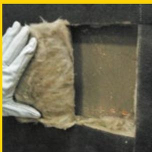
**2** Abre el **Ecovent®** tipo ventana para colocación del soporte.
