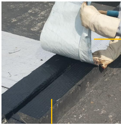
Manto SIN LLAMA PRO retirando foil de superficie.
